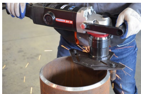
Anfasen von Rohren
